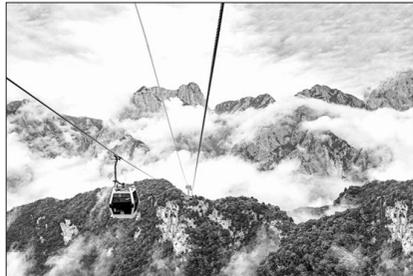
华山太华观光索道,是迄今为止世界上第一条采取崖壁开凿洞室站房、起伏式走向、设中间站的单线循环脱挂式索道,索道设备引进自法国波马公司,整体安全与运营系统采用最尖端的客运索道技术。其线路长达4211米,单向运量达每小时1500人
